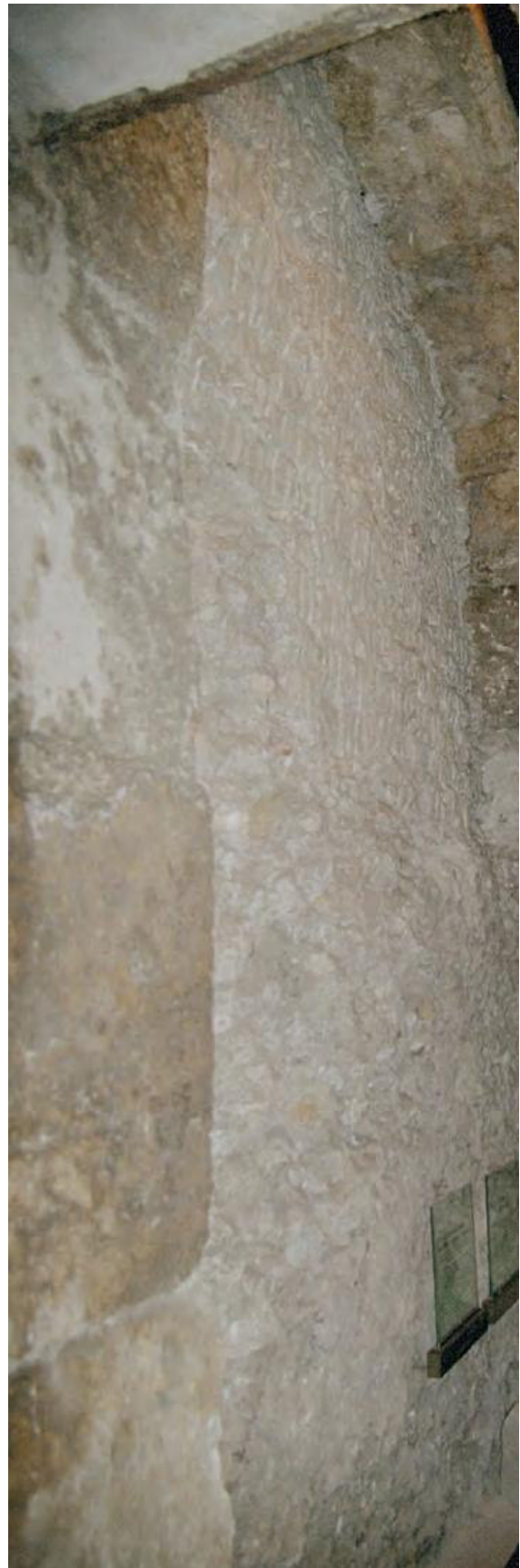
Abb. 9 Das zubetonierte Warren-Tor im Westmauer Tunnel
